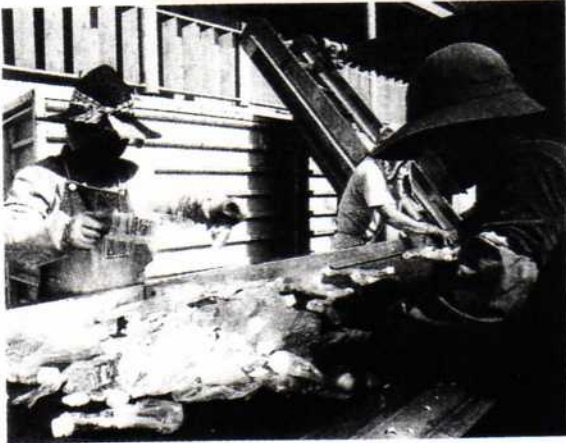
収集されたペットボトルは手選別で異物が取り除かれる。写真はペットボトルのラベルをはがす作業。
